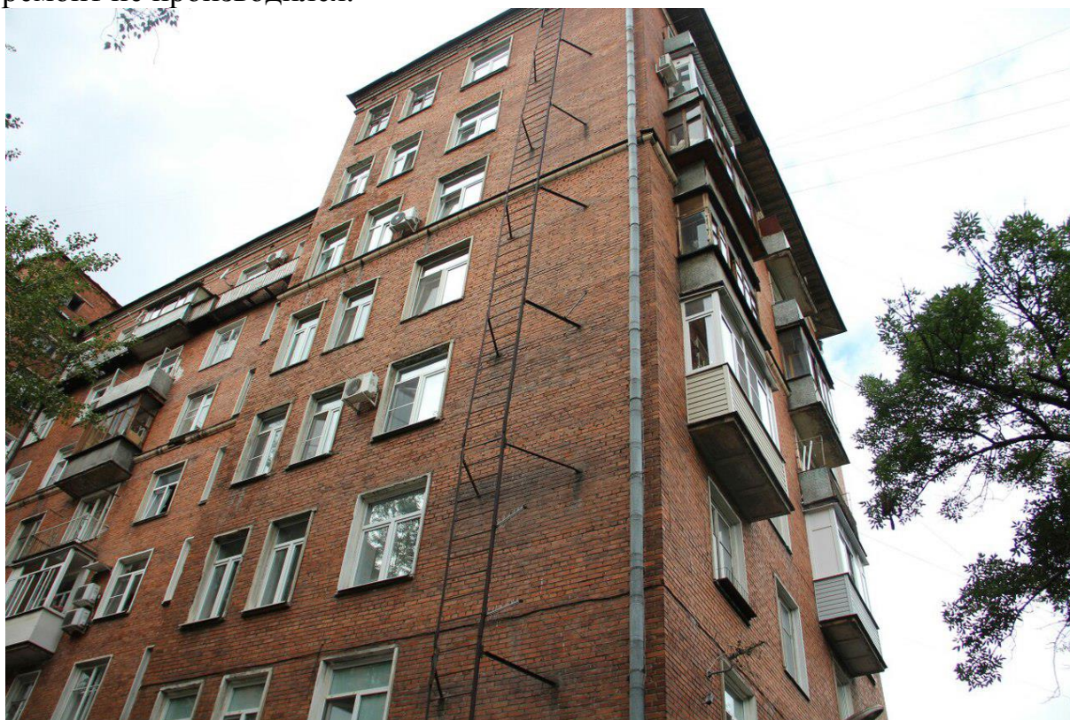
Рисунок 1. Фасад обследуемого здания
