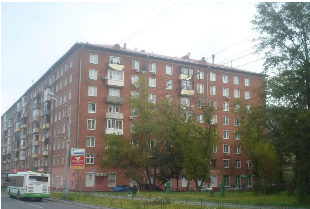
Рисунок 1. Фасад обследуемого здания
