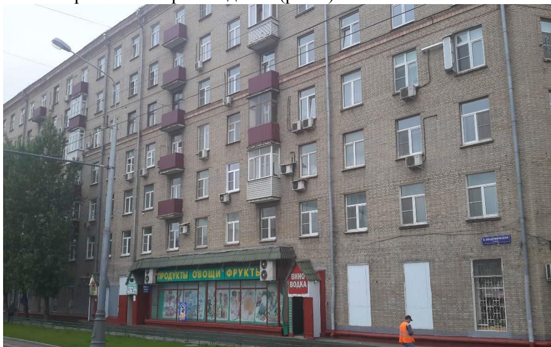
Рисунок 1. Фасад обследуемого здания
