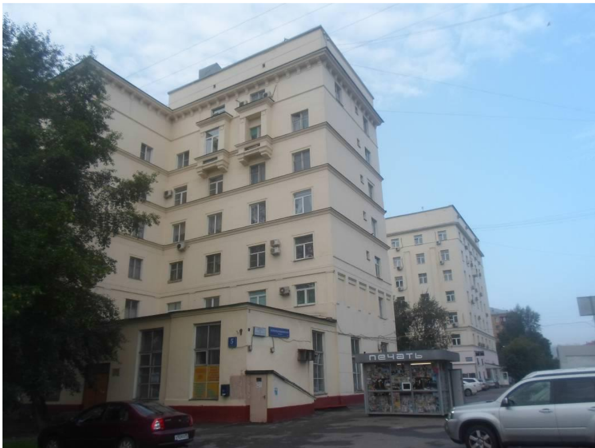
Рисунок 1. Фасад обследуемого здания
