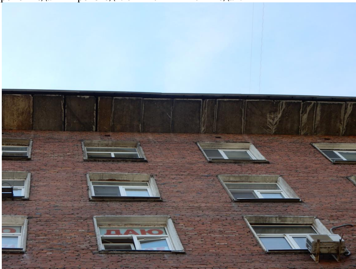
Рисунок 1. Фасад обследуемого здания
