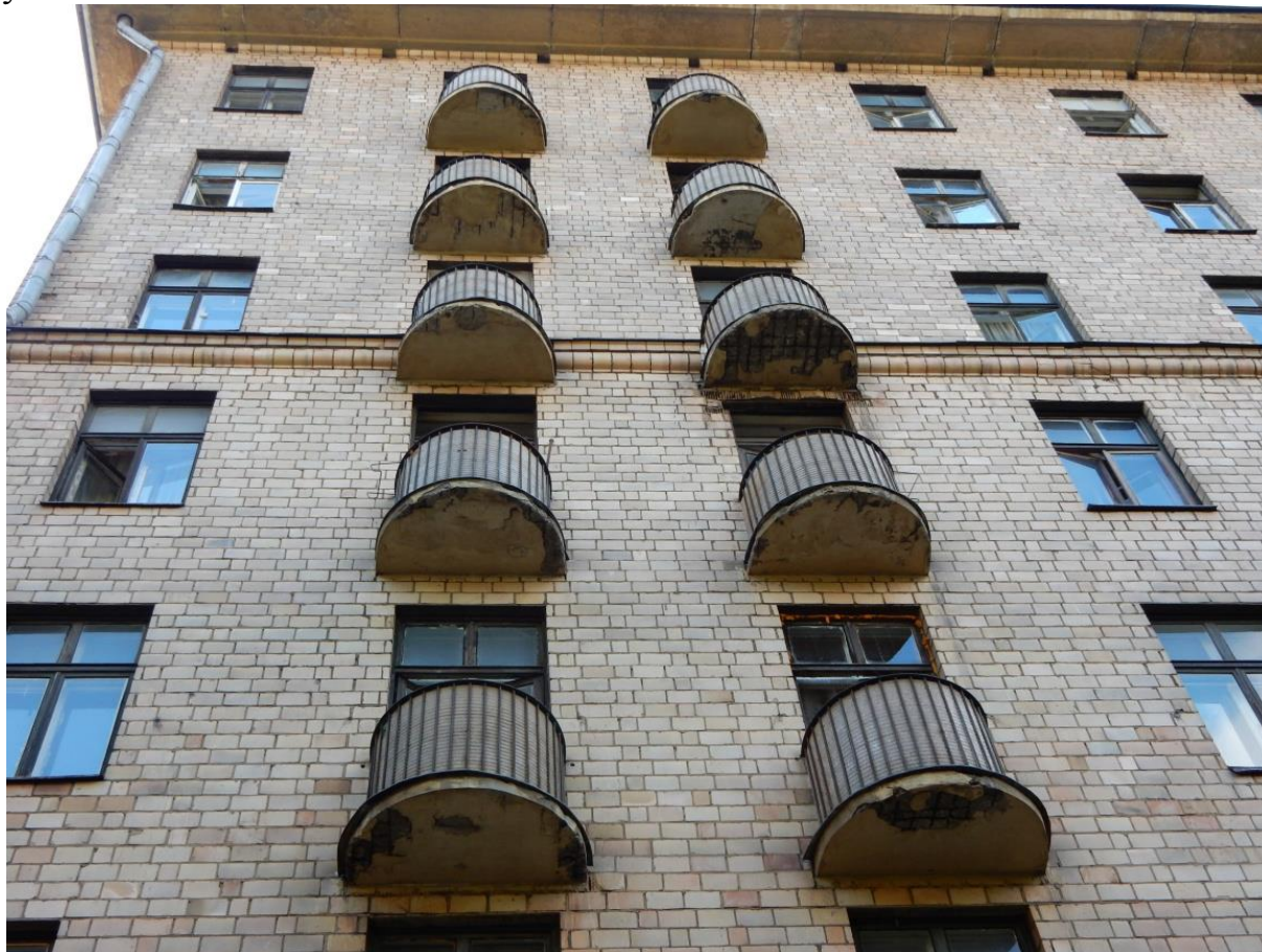
Рисунок 1. Фасад обследуемого здания
