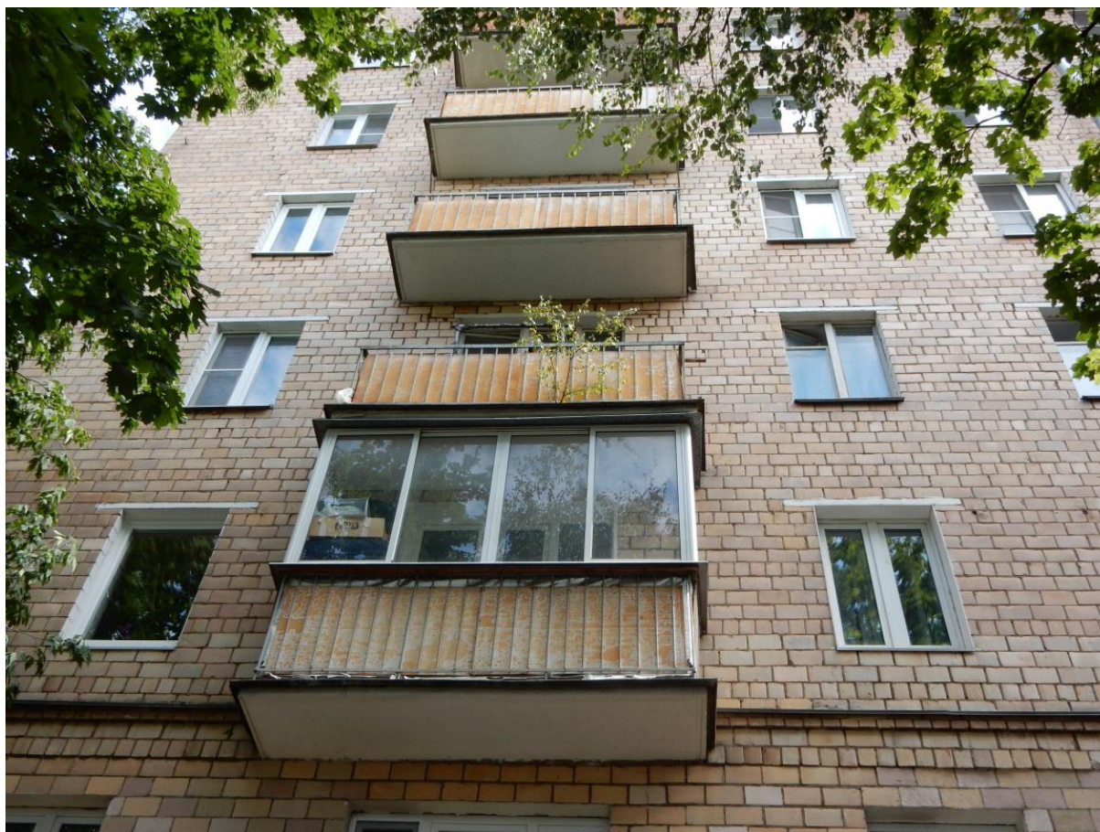
Рисунок 1. Фасад обследуемого здания
