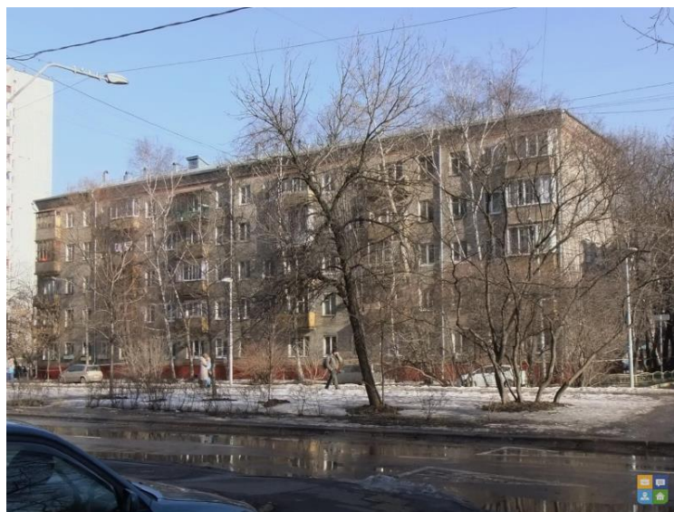
Рисунок 1. Общий вид обследуемого здания
