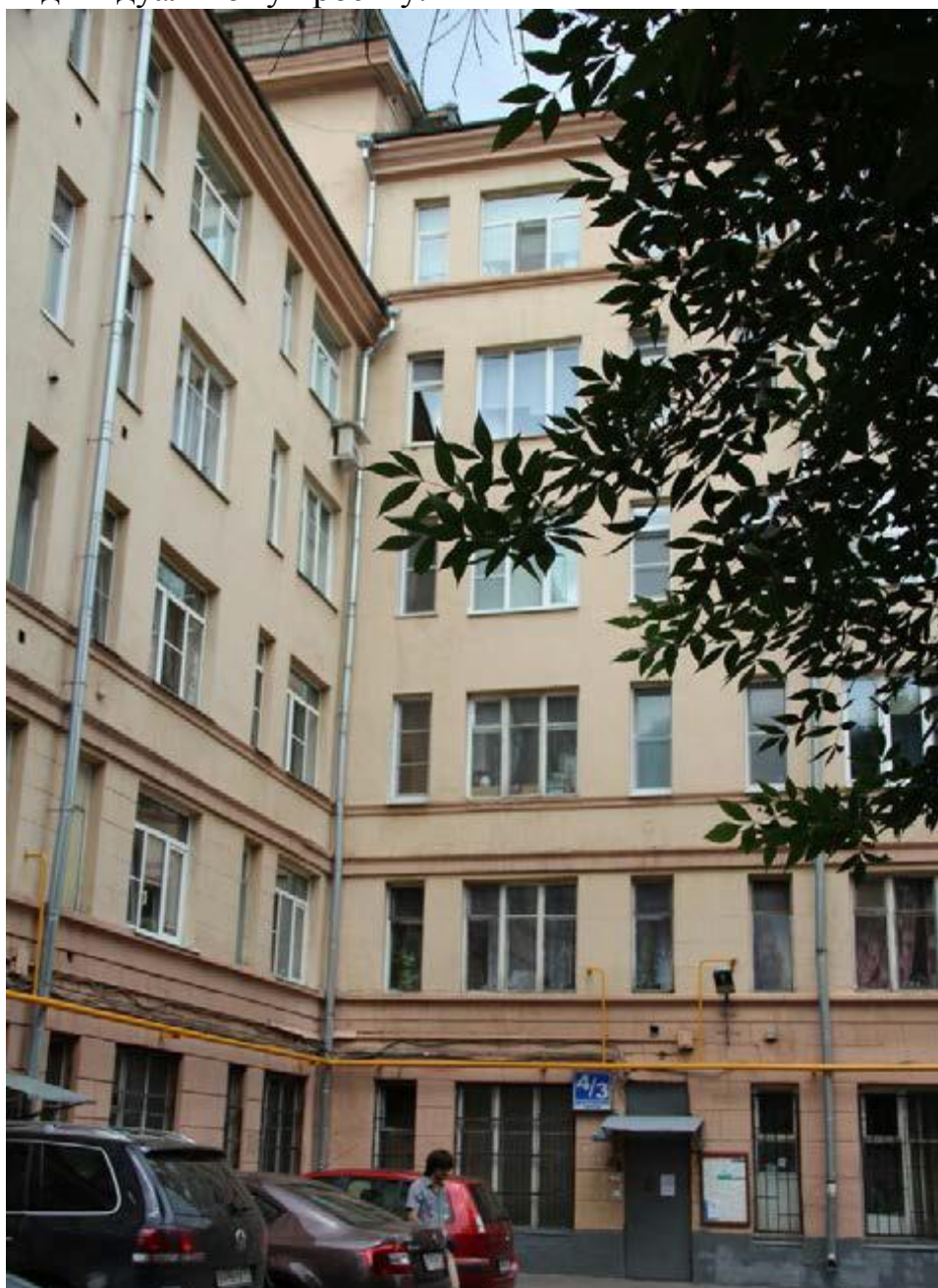
Рисунок 1. Фасад обследуемого здания
