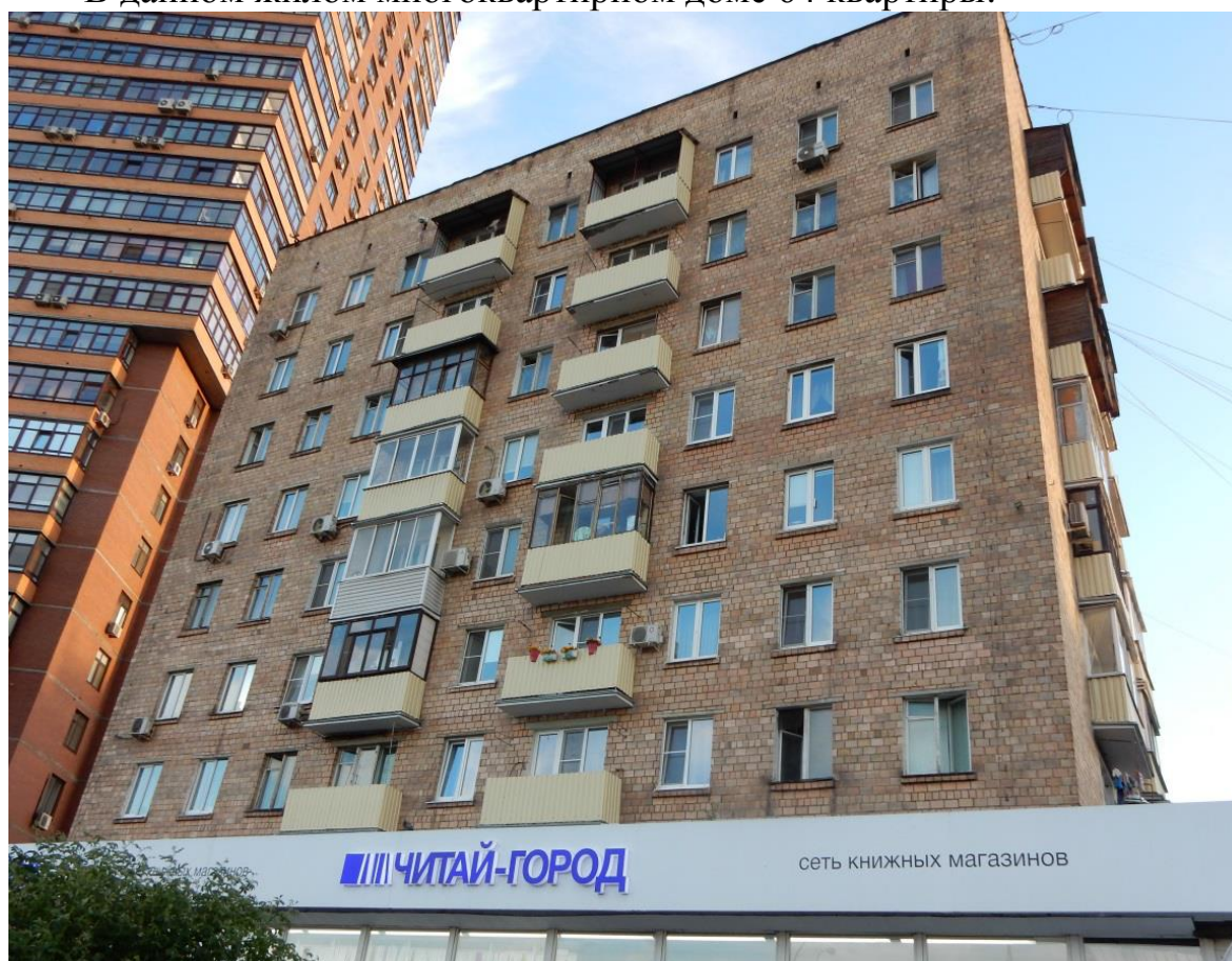
Рисунок 1. Фасад обследуемого здания
