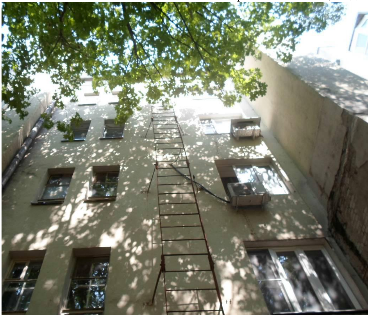
Рисунок 1. Фасад обследуемого здания
